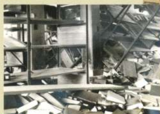
福井地震で倒壊した書庫
