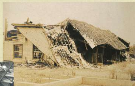
福井地震で倒壊した建物(福井工業専門学校)
