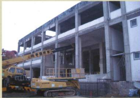
解体工事が進み柱だけになった旧図書館
